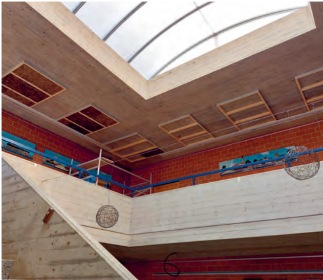
Reckholdern: Montage schallabsorbierender Deckenpaneele
